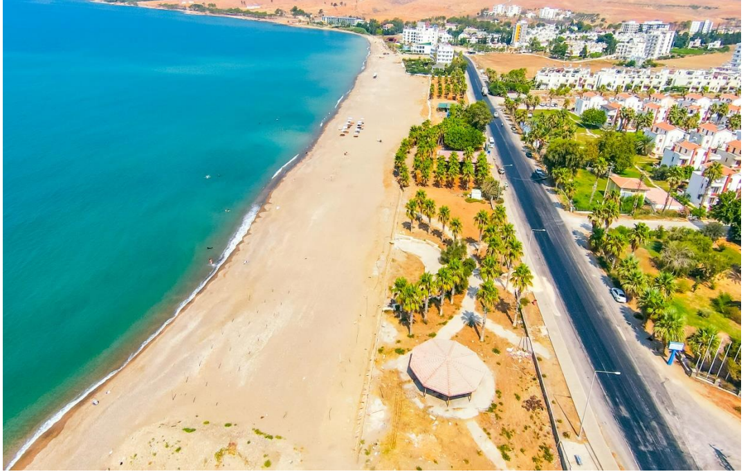
Yeşilovacık Mahallesi Sahil Düzenlemesi
