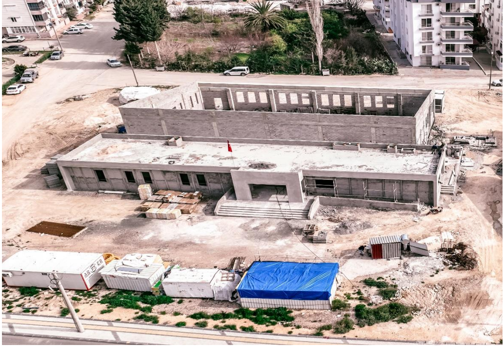
Yarı Olimpik Yüzme Havuzu İnşaata
